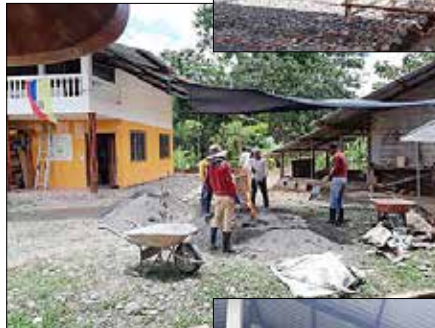
Der Freiluft-Schulraum ist fertig
